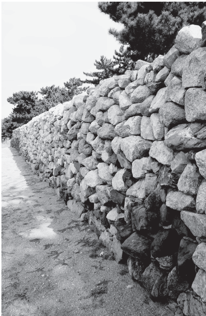
Fig. 5 - Particolare del genkō bōri ad Ikinomatsubara
